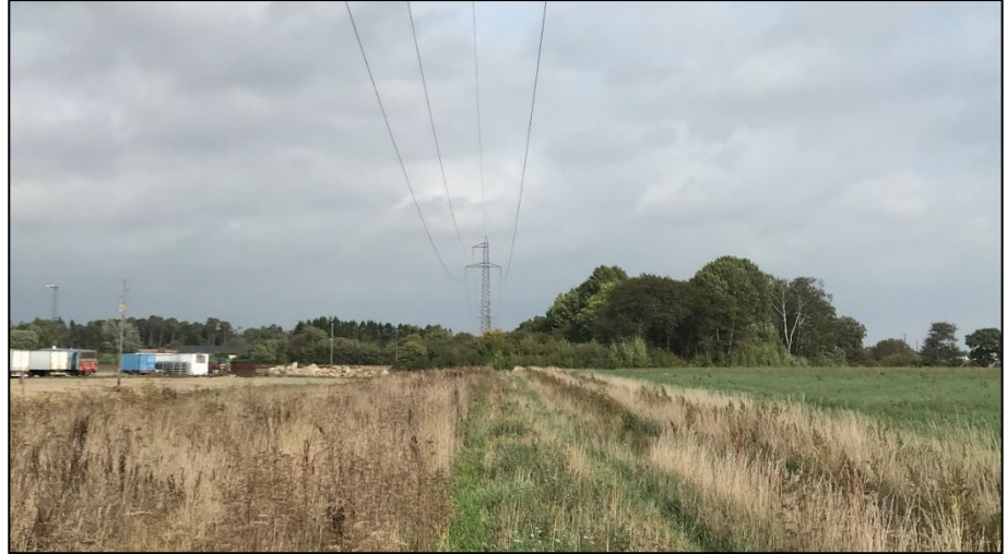
Regionnätsslufsledningens östra stolpe vid dungen inom fastigheten Ramsåsa 37:1 sett från sydväst.
