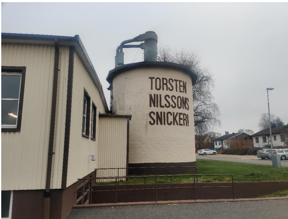
Figur 6. Silo med bullerkälla på tak i verksamhetens södra del
