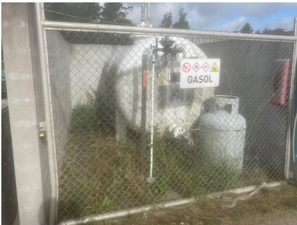
Figur 5. Gasoltanken är omsluten av en betongkonstruktion på tre sidor. Foto taget från öster.
