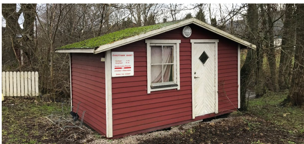
Byggnad tillhörande badet, sedd från öst. Foto: Marcus Carlevåg, 2018-02-01.
