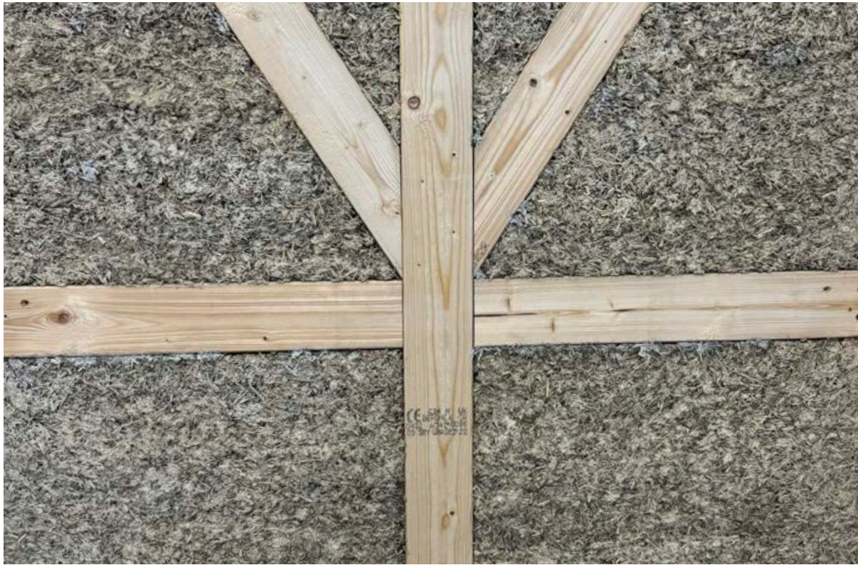
Hampaisolering är exempel på ett regenerativt byggt teknik där hampaväxten bidrar till kolinlagring och har jordförbättrande egenskaper.
